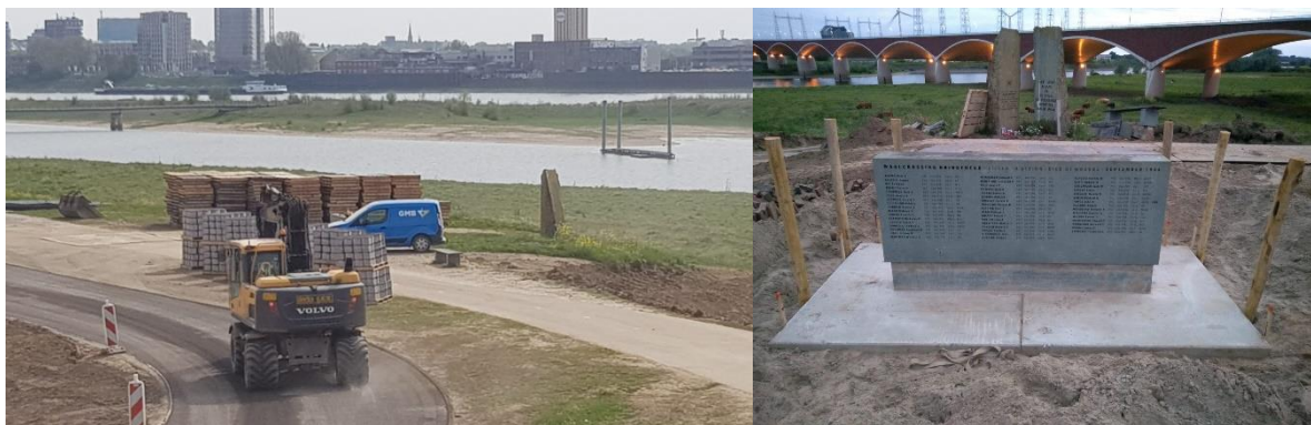
Figuur 4: Werkzaamheden rondom het monument tijdens de dijkverzwaring (foto: Henk Hanenburg/Douwe Osinga)
